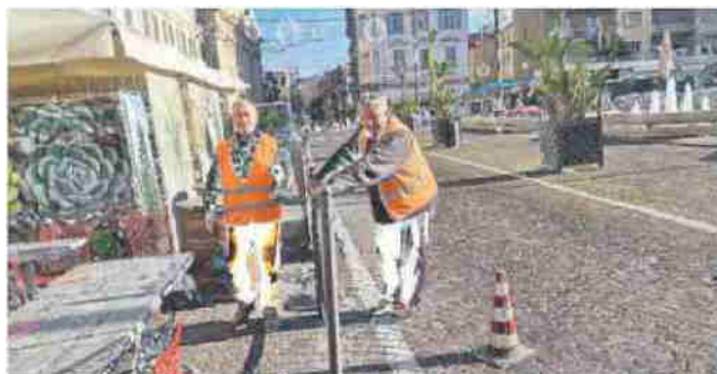
Anche i cantieri edili possono ripartire da oggi
