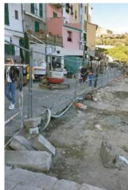
LAVORI IN CORSO Ecco come si presenta la calata di Porto Venero, ieri sono stati posizionati i tubi della nuova condotta Acam
