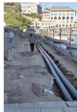
LAVORI IN CORSO Ecco come si presenta la calata di Porto Venero, ieri sono stati posizionati i tubi della nuova condotta Acam
